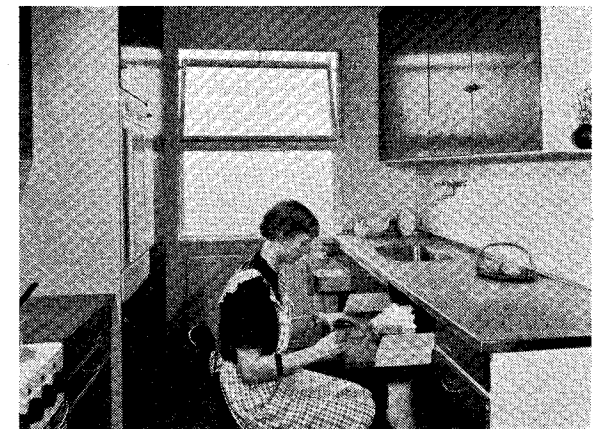
Fig. 5. Køkken udført af fabriksfremstillede enkeltdele svarende til Dansk Køkkensæts elementkøkkener. De enkelte elementer er fabriksfremstillede og behandlede inden opstillingen på byggeplads.
